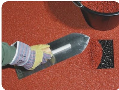
Укладка травмобезопасного покрытия
